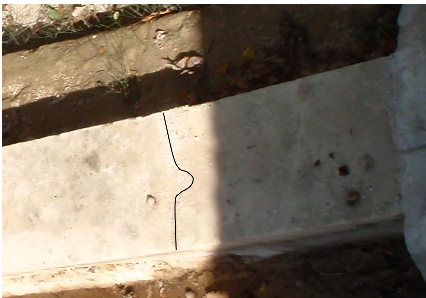
Détail de l'assemblage des pierres de la margelle
